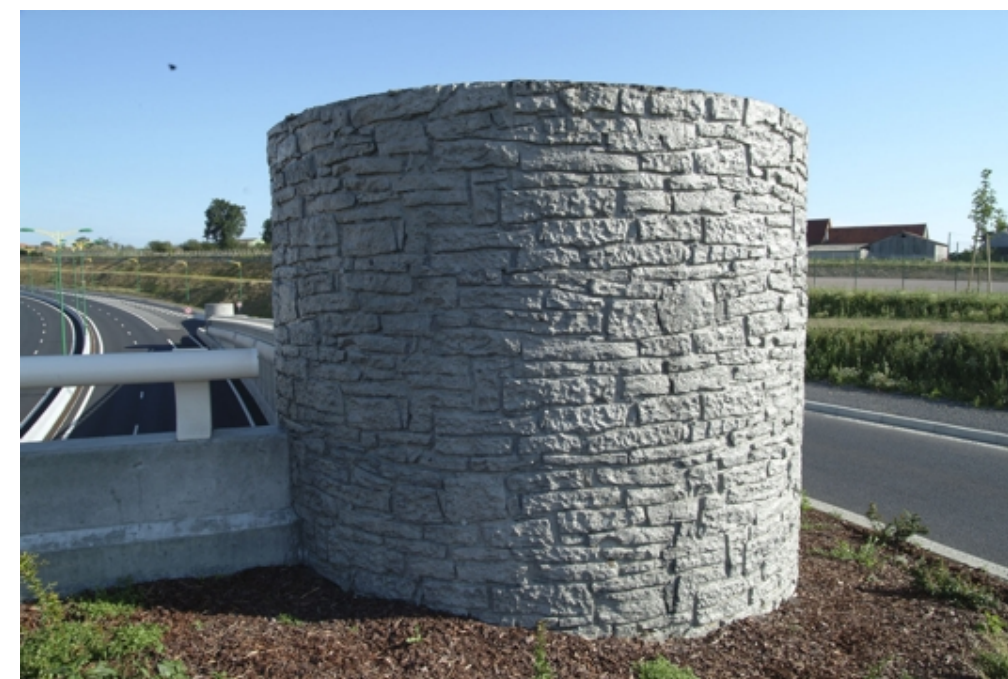
příklad realizace reliéfní betonové stěny
